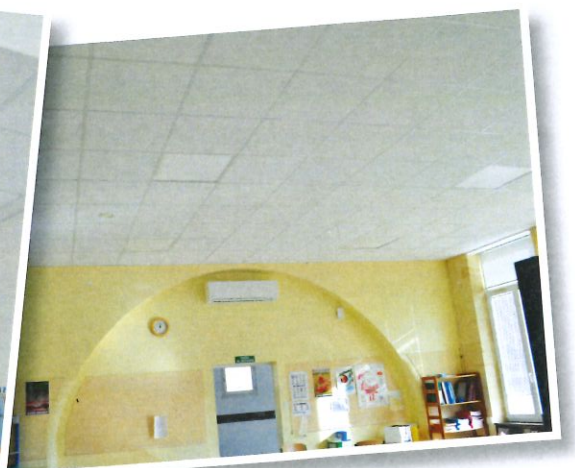
▲ Réfection des faux plafonds et de l'éclairage des salles de classe de l'école.
